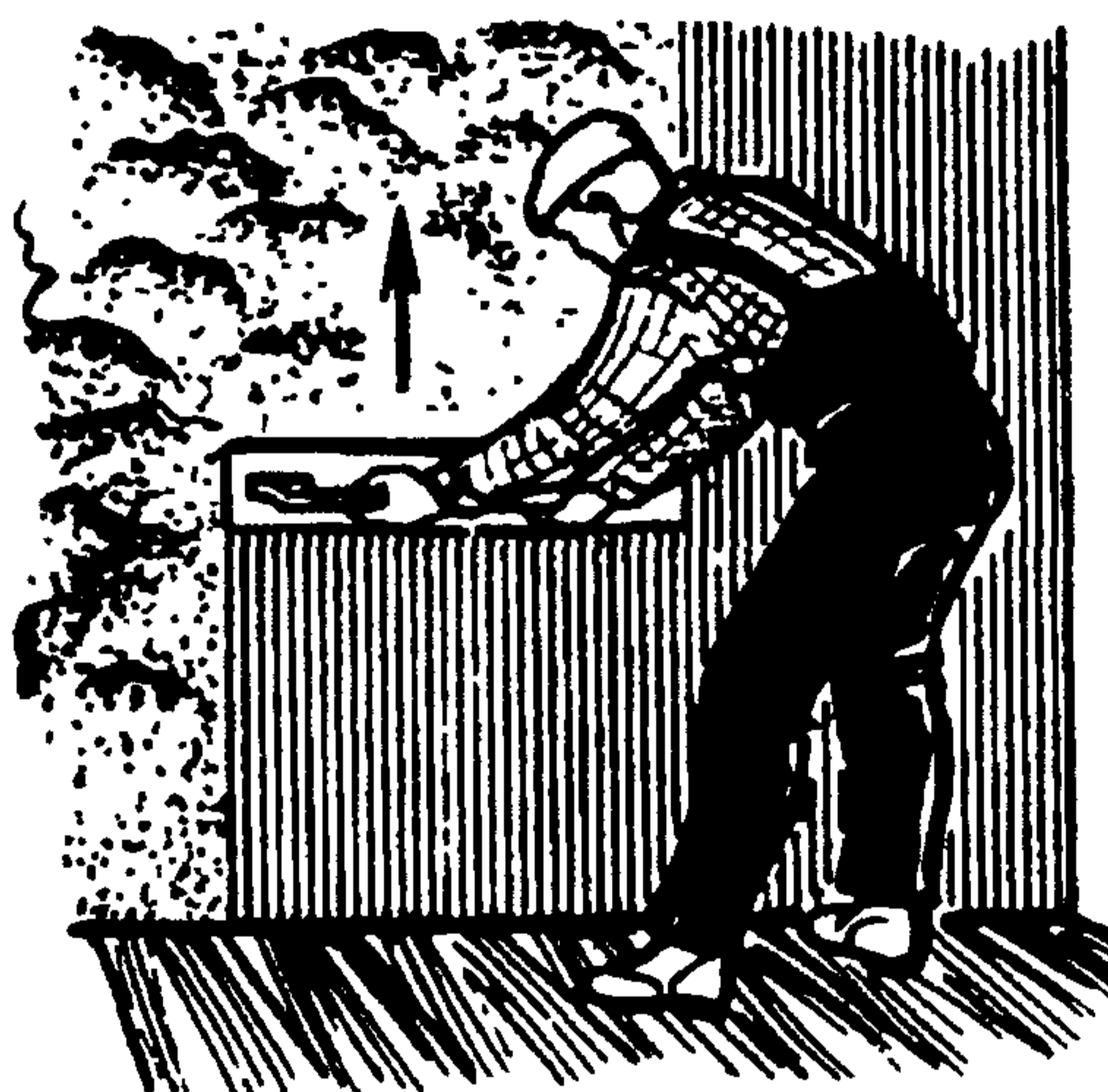
Рисунок 6 – Разравнивание раствора полутерком
