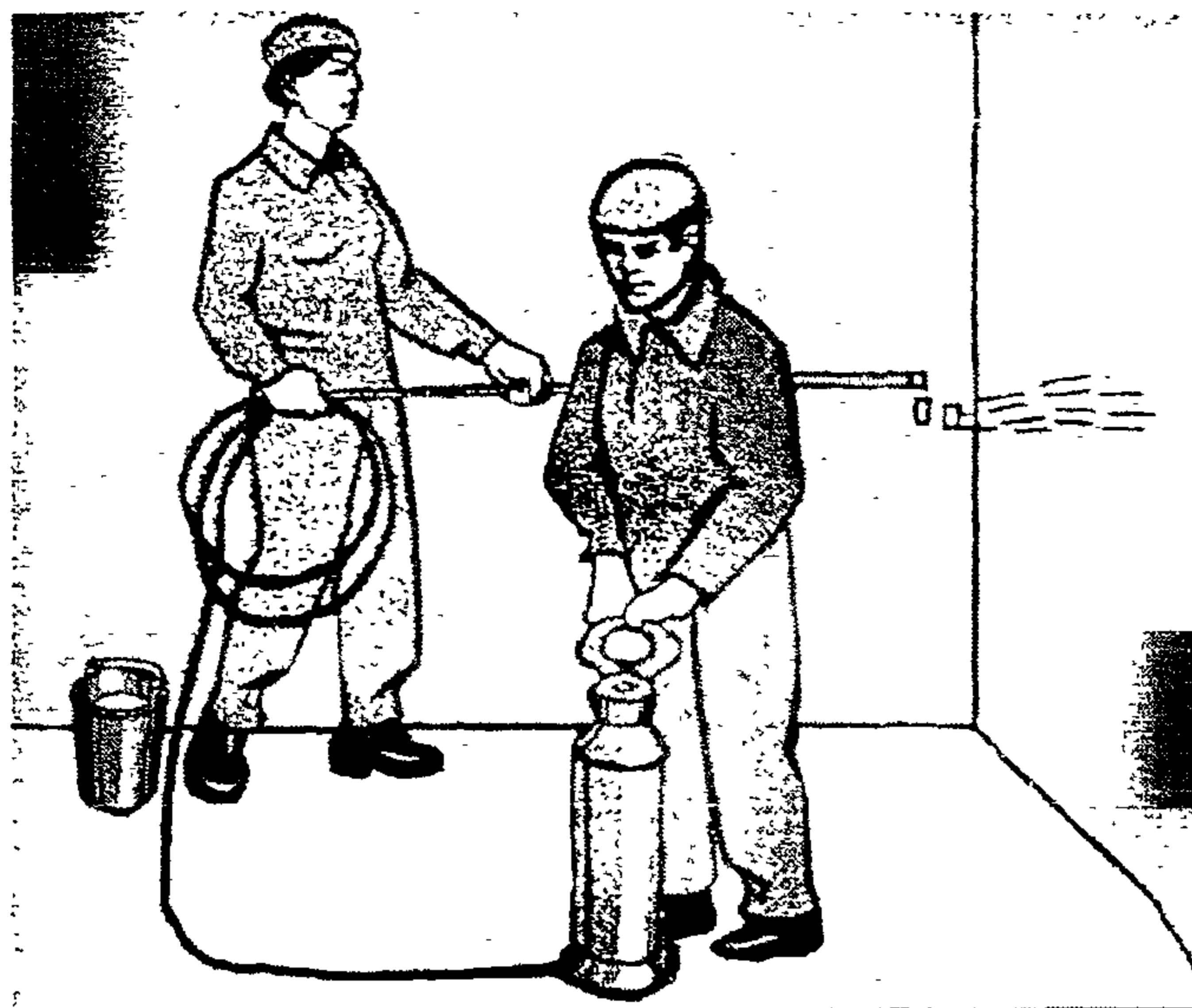
Рисунок 10 – Огрунтовка поверхности стен краскопультом
