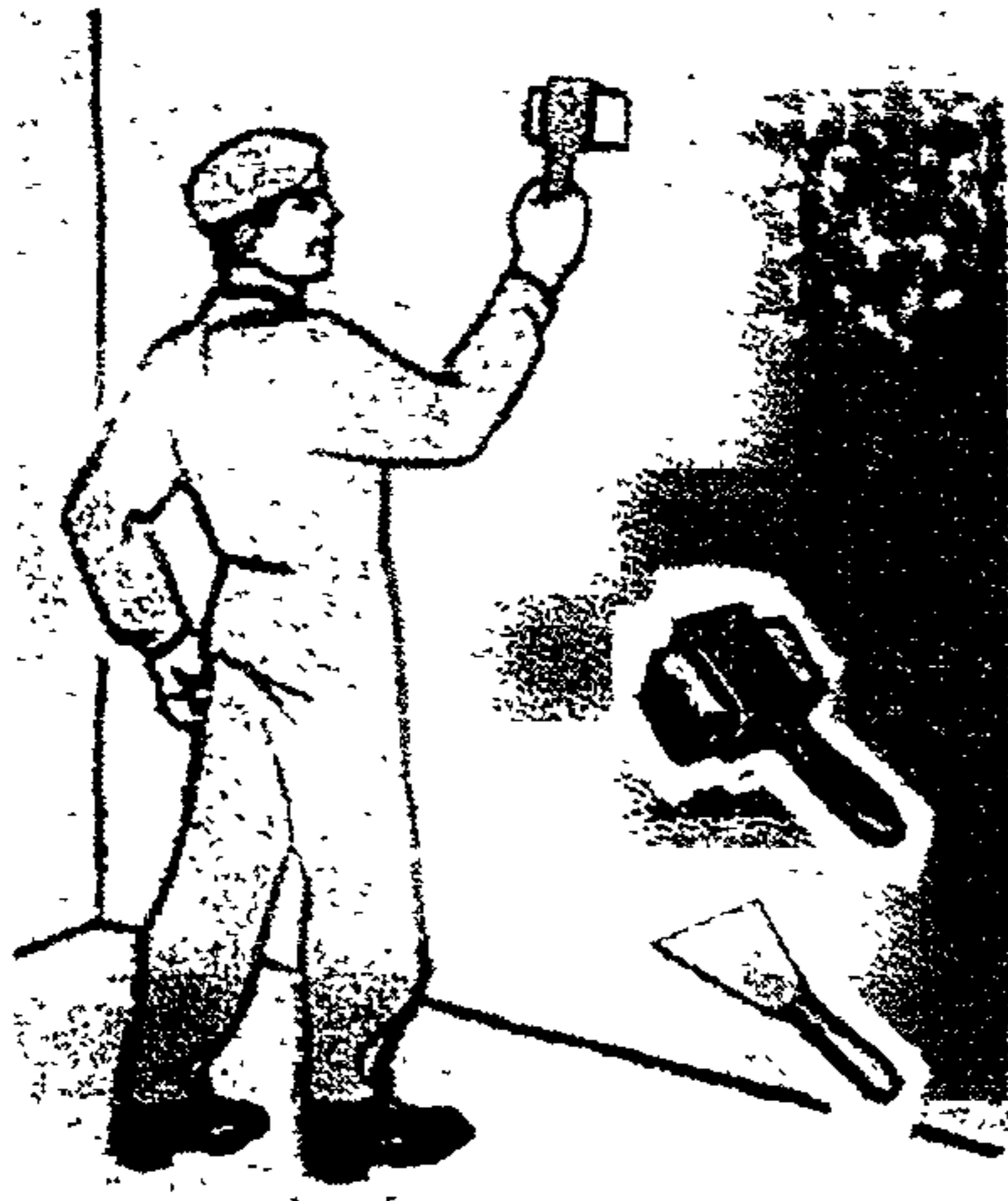
Рисунок 6 – Очистка поверхности стен с помощью металлического скребка и лещади
