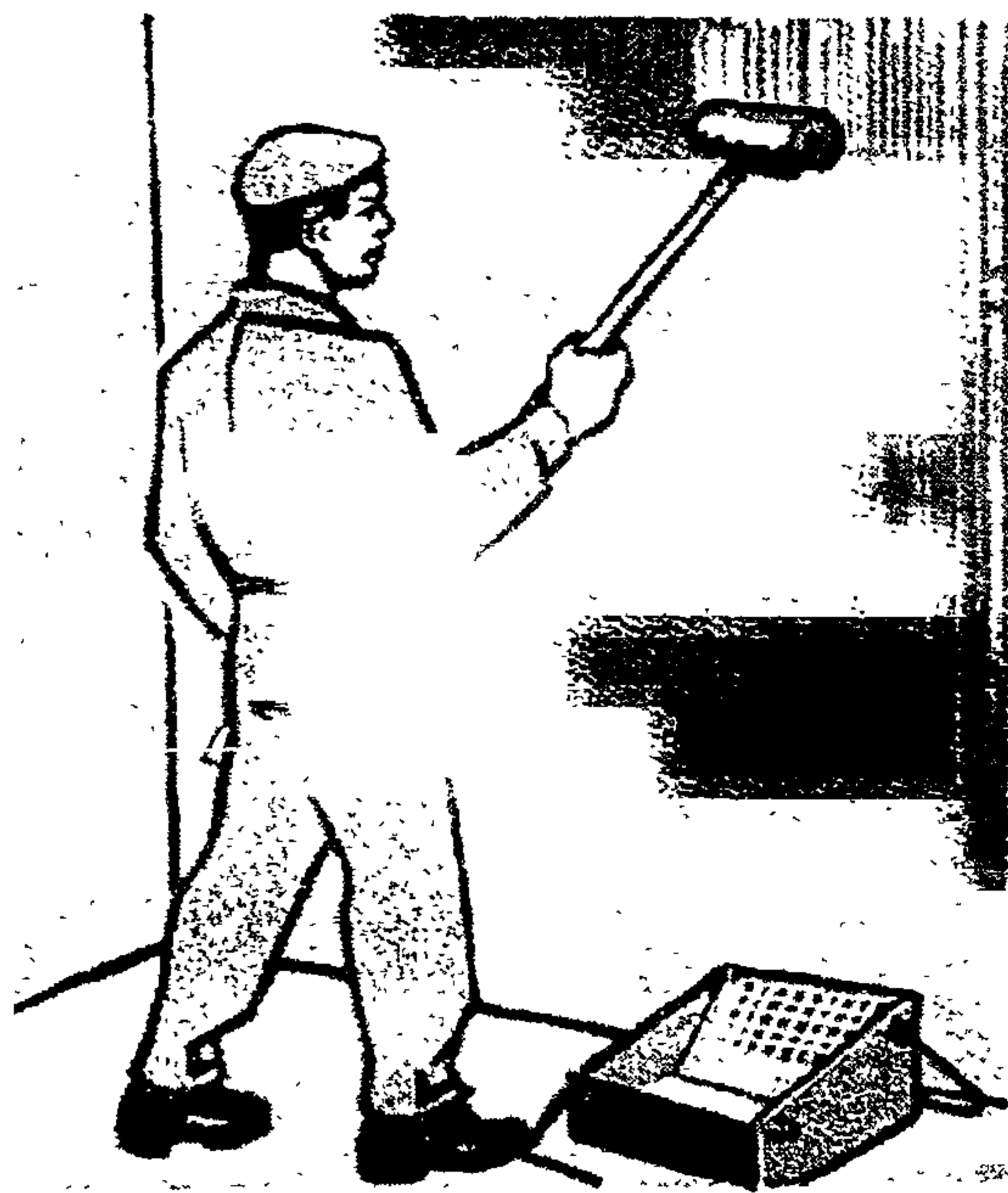
Рисунок 11 – Огрунтовка поверхности стен валиком
