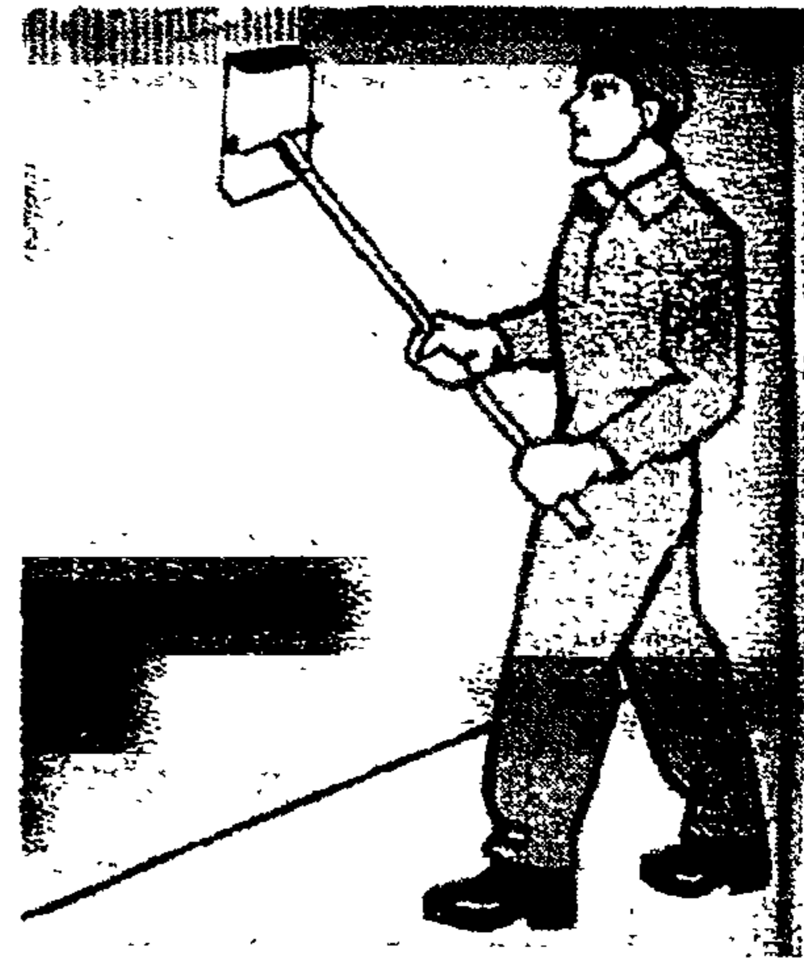
Рисунок 7 – Очистка поверхности с помощью шарнирной терки
