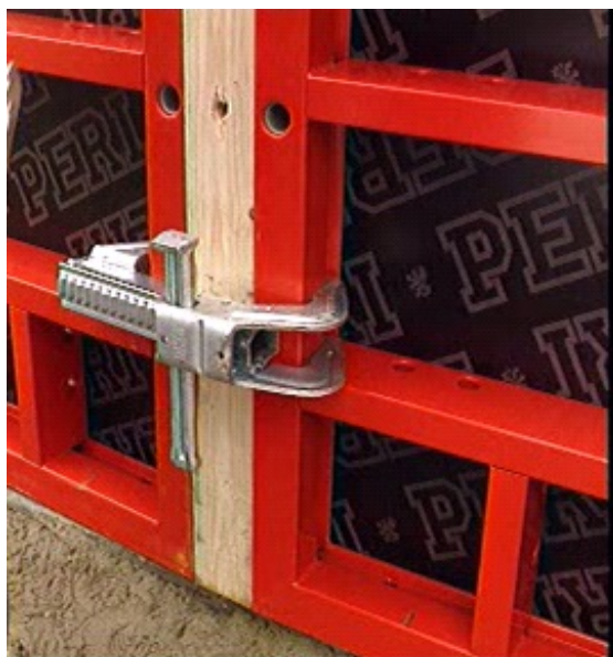
Рис. 13. Соединение щитов с помощью замков опалубки
